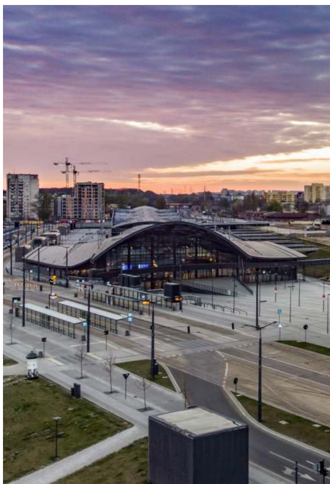
Łódź Fabryczna - najnowocześniejszy dworzec kolejowo-autobusowy w Polsce
