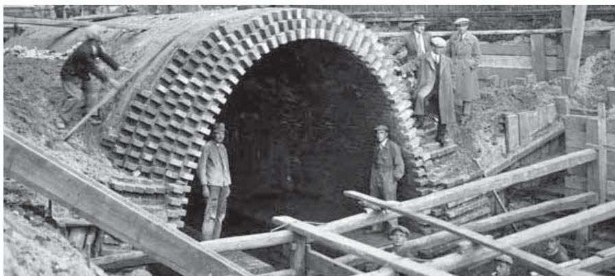
Budowa kolektorów i sieci wodociągowej była dla Łodzi dużym wyzwaniem
