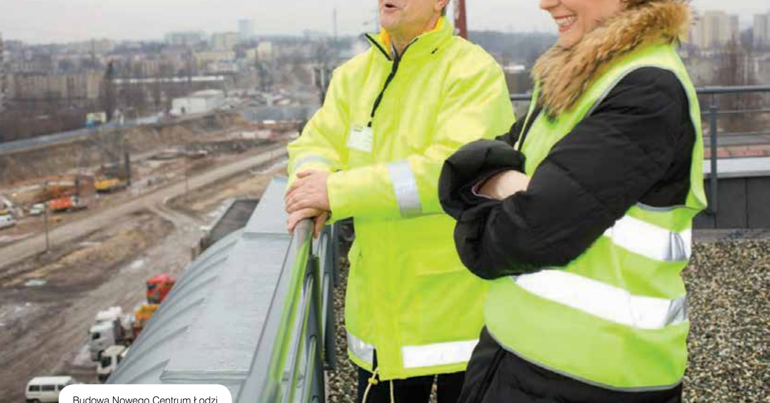
Budowa Nowego Centrum Łodzi
